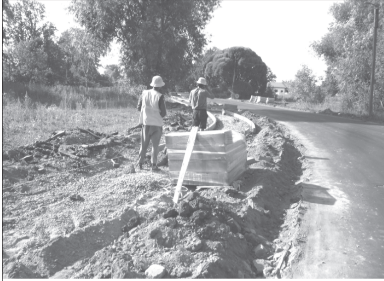
Новая дорога на ул. Фрунзе: будет безопасно и красиво
